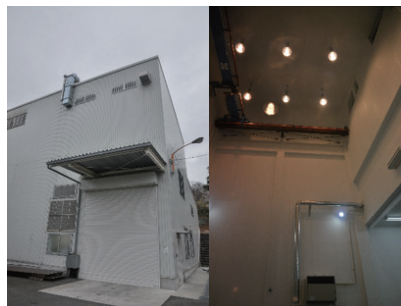
スーパーレジン工業津久井工場宇宙棟 衛星組立用クリーンルーム (クラス 10 万) 222 m 2
